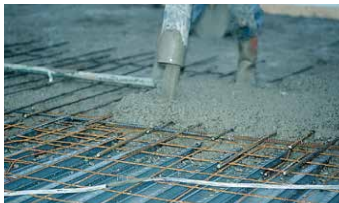
Betongen ska utbredas jämt så att plåten inte får lokala nedböjningar.
