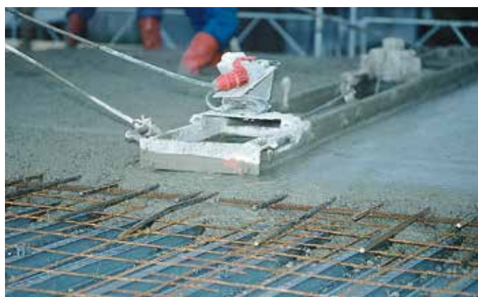
Betongpågjutning görs till färdig yta i ett moment.
