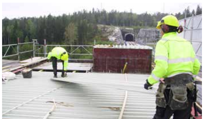
Cofraplus 45 väger bara 7,5 kg/lm och kan oftast monteras utan lyfthjälpmiddel.
