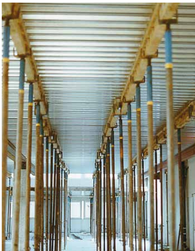
Ett glest lager bockryggar stöttar plåten under gjutfasen.
