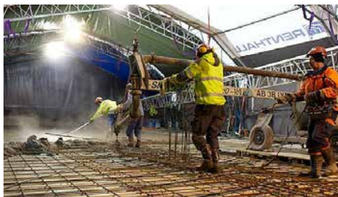
Vid pågjutning av större ytor planeras etappavstängning.
